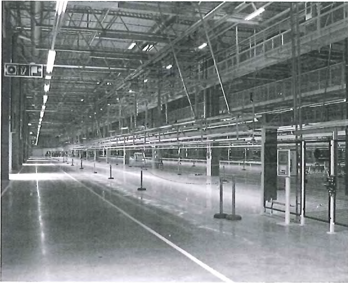
Das Innere der Montagehalle.
