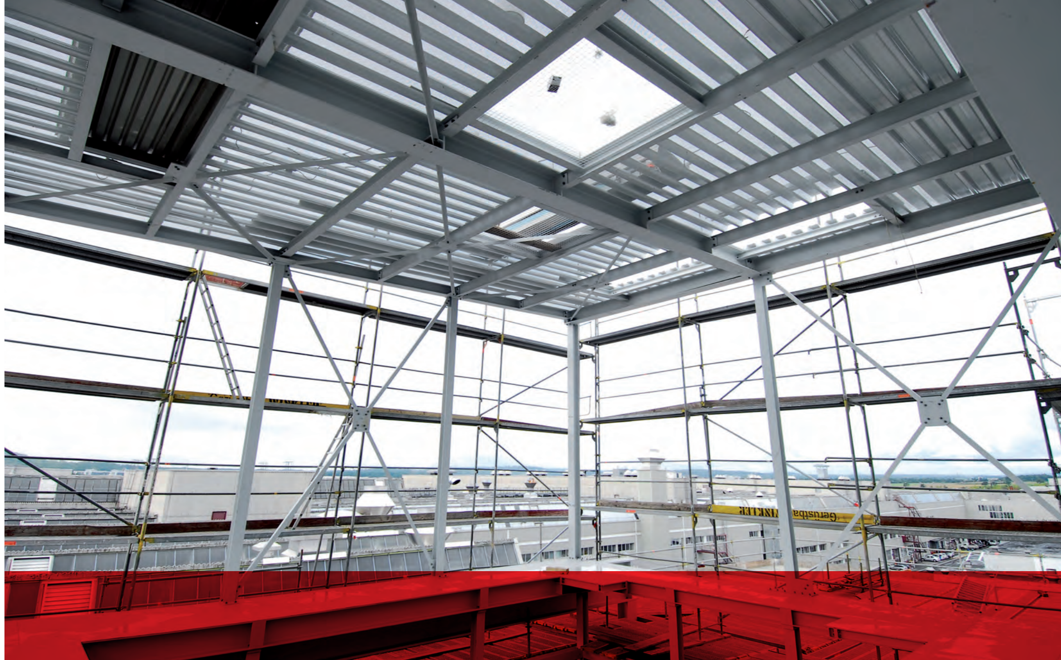
Die nachträgliche Aufstockung des Gebäudes erfolgte mittels einer Leichtbaukonstruktion.
