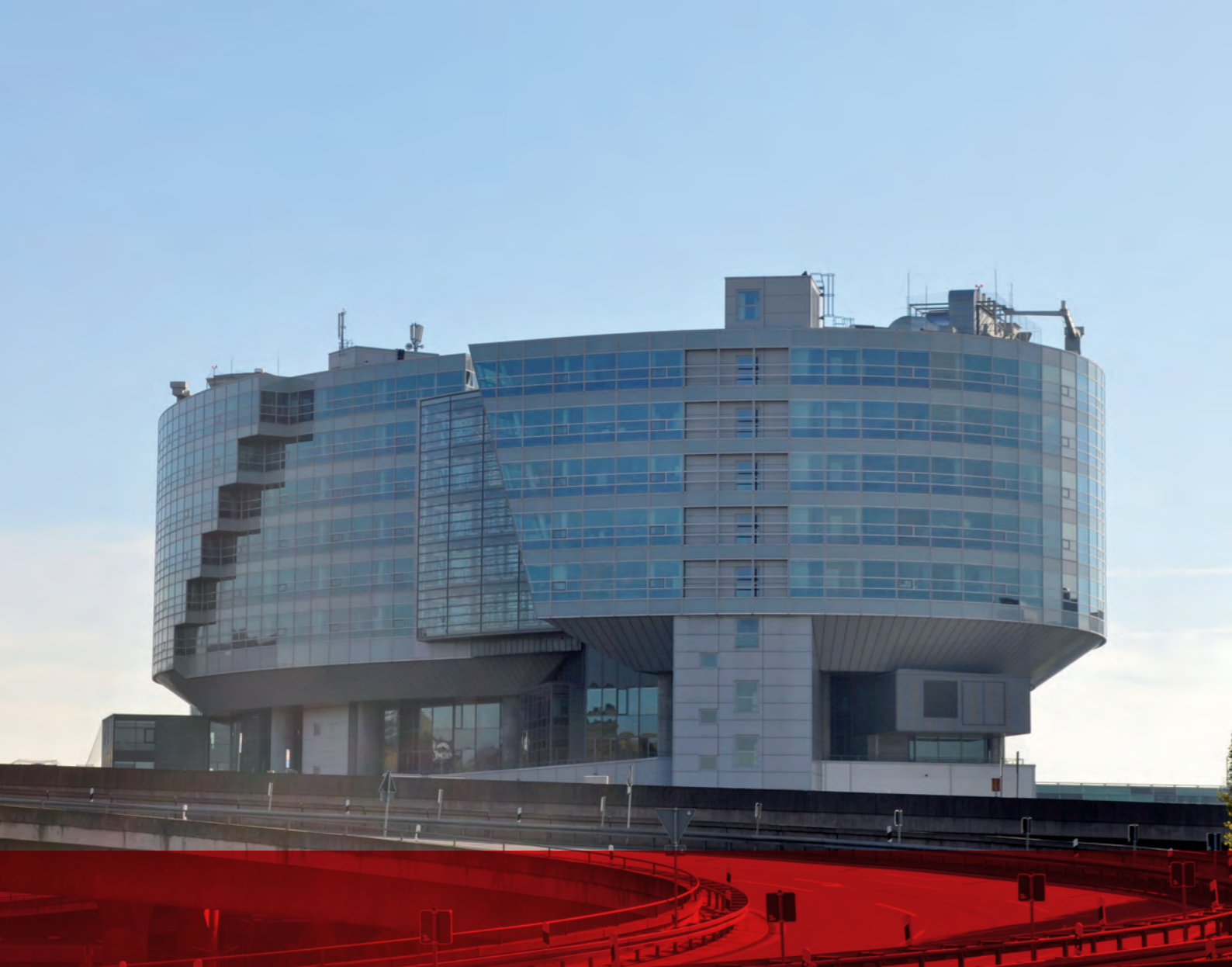
VTC Van Technologie Center, Stuttgart
