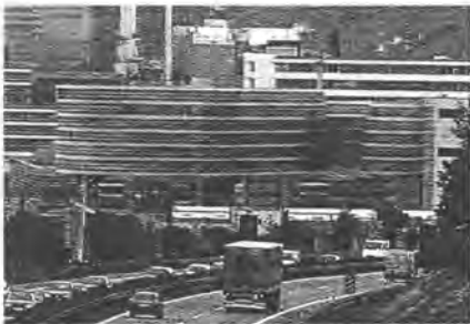
Das Baufeld liegt im Norden des Werksgeländes und grenzt direkt an die Auffahrt zur B 14
